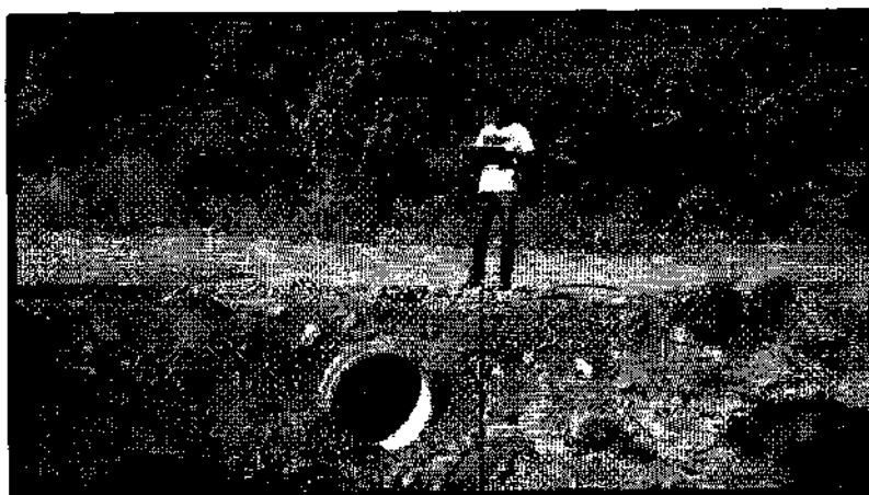
Figura 8.2 –Acréscimo de tubos e Limpeza de área assoreada estaca 132.
